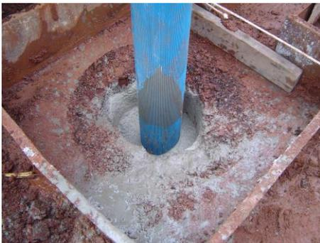
A cimentação é feita entre o tubo de boca (revestimento externo) e a parede do furo para proteger o poço de algumas contaminações mais rasas, como fossas, por exemplo.
